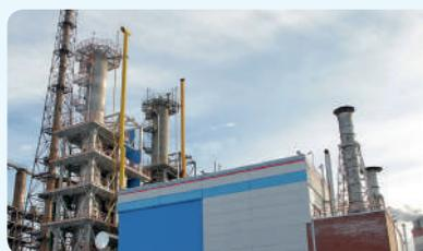
На производстве азотной кислоты внедрена система двойного орошения на абсорбционных колоннах, обеспечена бесперебойная работа узла кислотного улавливателя в цехе карбамида.
